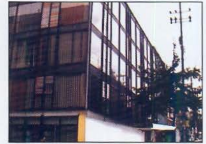
Fachada de las oficinas provisionales del Tribunal Superior Agrario en la calle de Morena.
